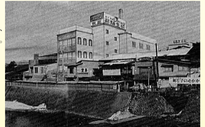
完成当時の飛騨生協会館（1970年）
