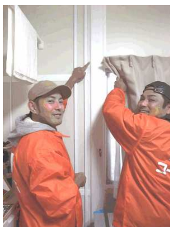
■設置作業の様子■
