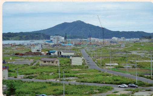
▲気仙沼市 震災4日後と2013年9月1日の同じ場所の光景。災害廃棄物はなくなったものの、一面、夏草が茂っている。
