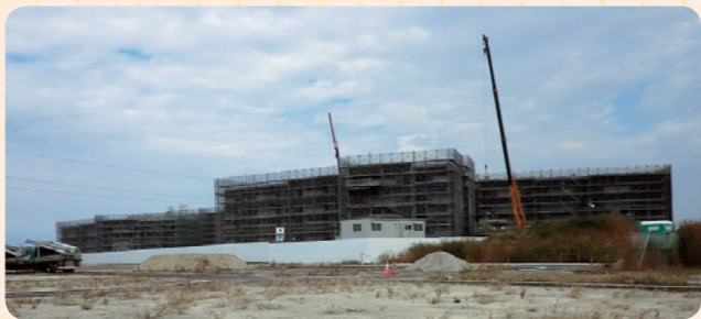
▲周辺に何も無い場所に建設が進む災害公営住宅(仙台市田子西地区)。しかし宮城県県の計画戸数15,754戸に対し工事が完了したのはまだ117戸にすぎない('13年8月31日現在)。
