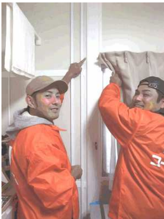
■設置作業の様子■
